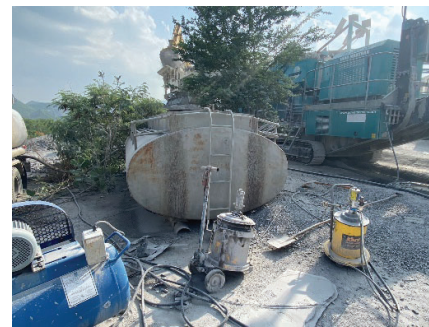
รูปที่ 2-29: การติดตั้งแท็งก์น้ำ บริเวณ Mobile Crushing
